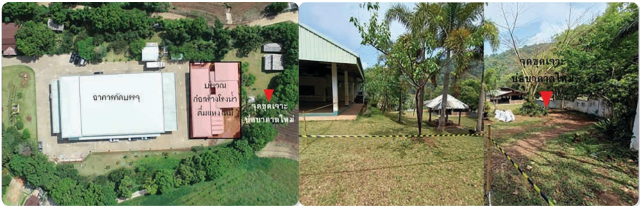
ภาพพื้นที่ขุดเจาะบ่อน้ำบาดาลแห่งใหม่
