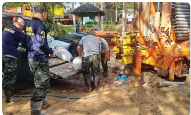
ภาพการขุดเจาะน้ำบาดาลในบริเวณพื้นที่โรงผลิตน้ำดื่มแห่งใหม่ ณ ศูนย์พัฒนาโครงการหลวงหนองหอย
